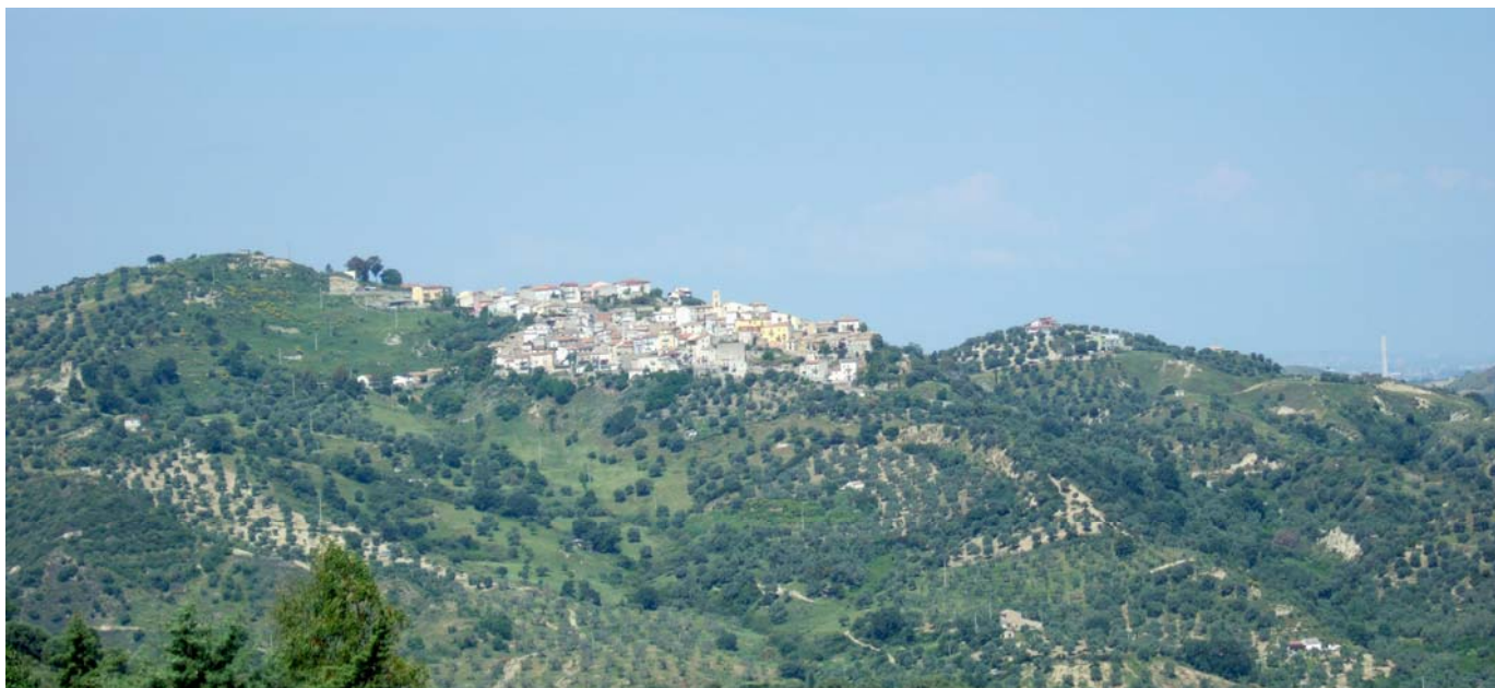
Figura 2 – Comune di Calopezzati – veduta del sistema collinare sul quale sorge il paese
