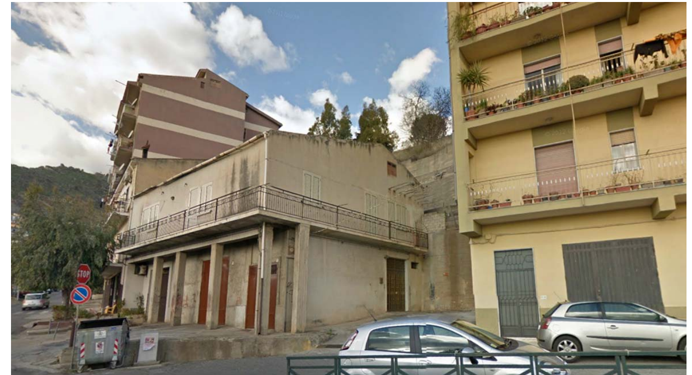
Figura 13 – Comune di Cassano allo Ionio, vista da via Vittorio Emanuele di alcuni degli edifici esclusi dal perimetro del centro storico definito dal PSA. La zona
