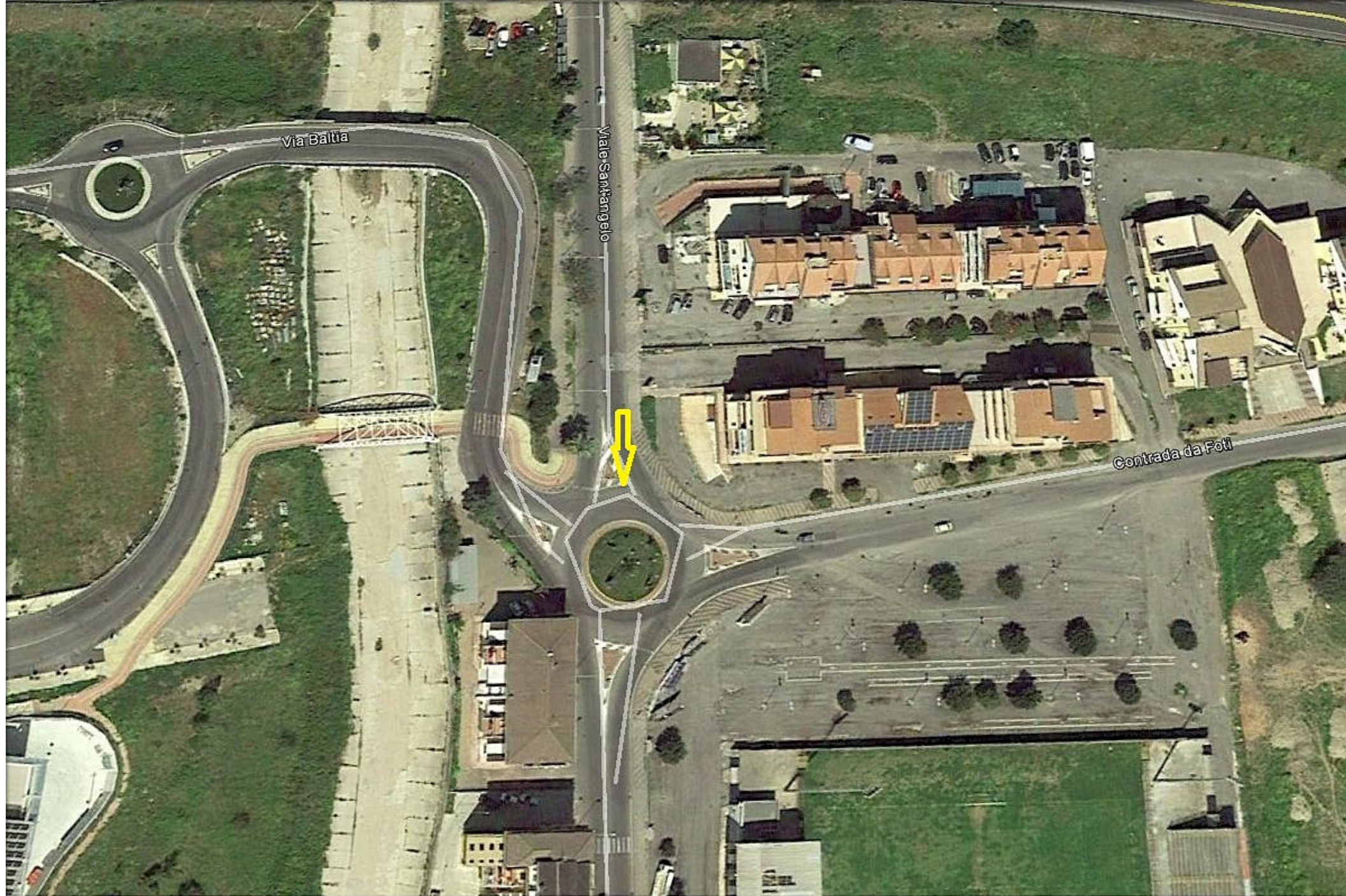
Rotonda V.le S. Angelo 78 mq. con impianto di irrigazione manuale.
