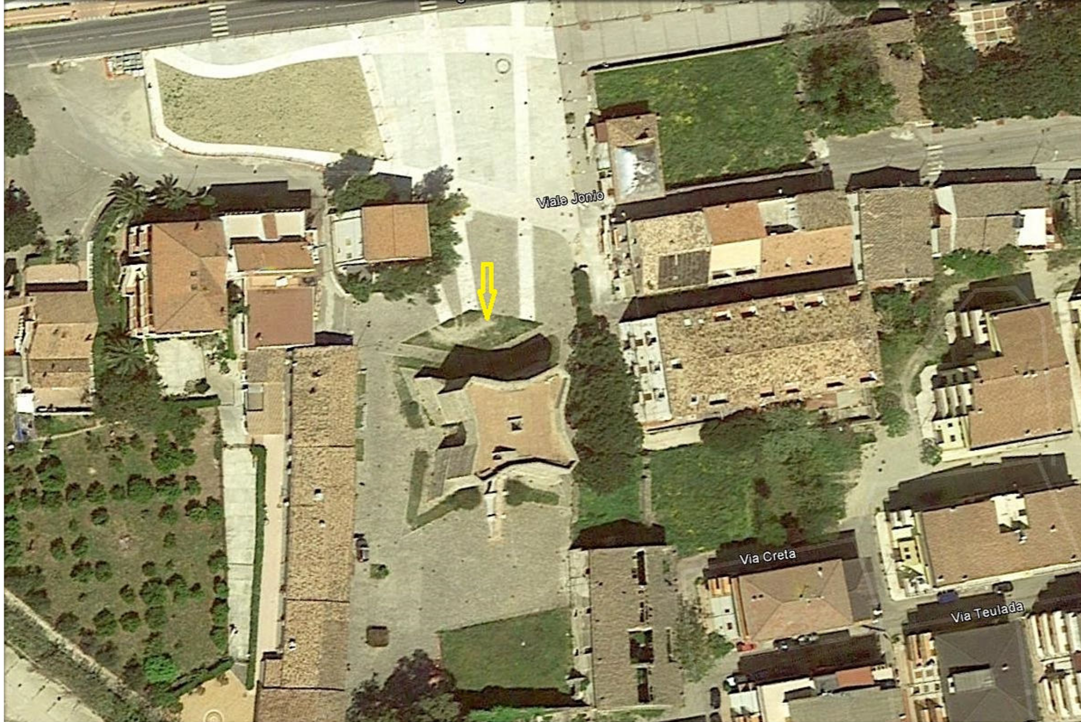
Torre Stellata Aree verdi con impianto di irrigazione manuale.
