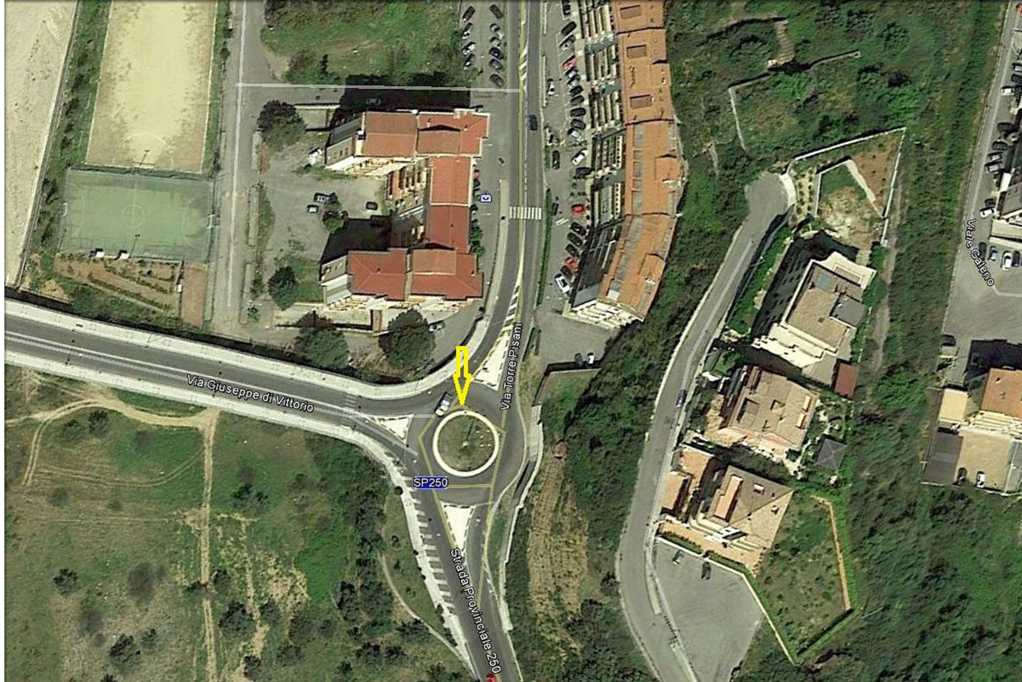
Rotonda Ponte Almirante 200 mq. senza impianto di irrigazione.
