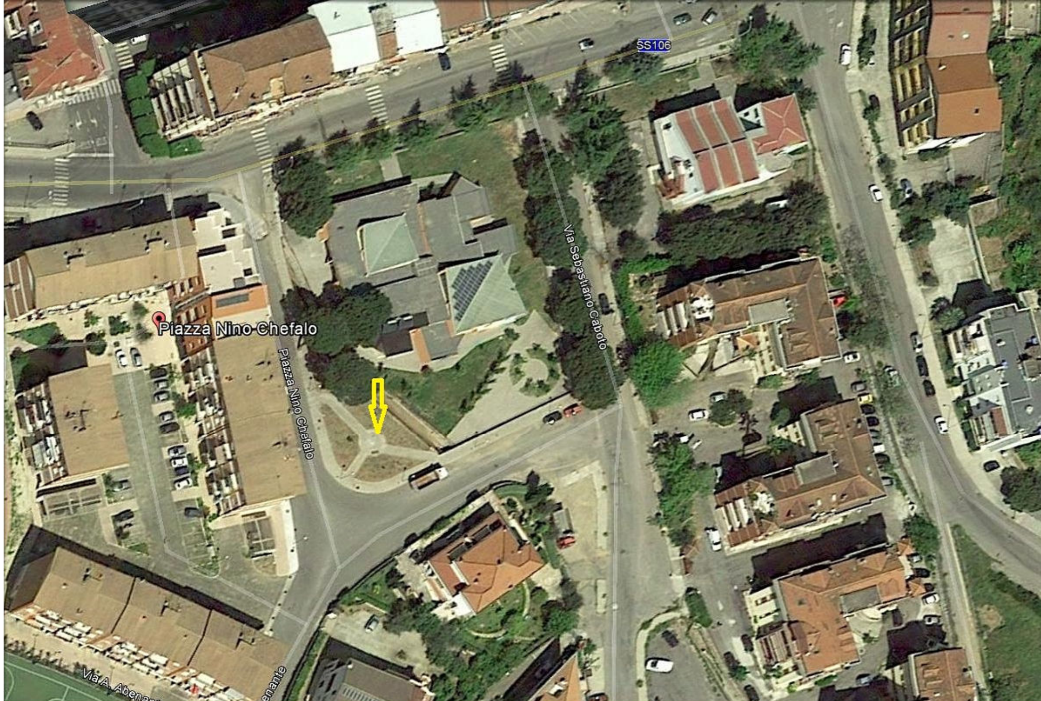
P.zza N. Chefalo incrocio Via Abenante -C.da Matassa- Area verde 25 mq. senza impianto di irrigazione.
