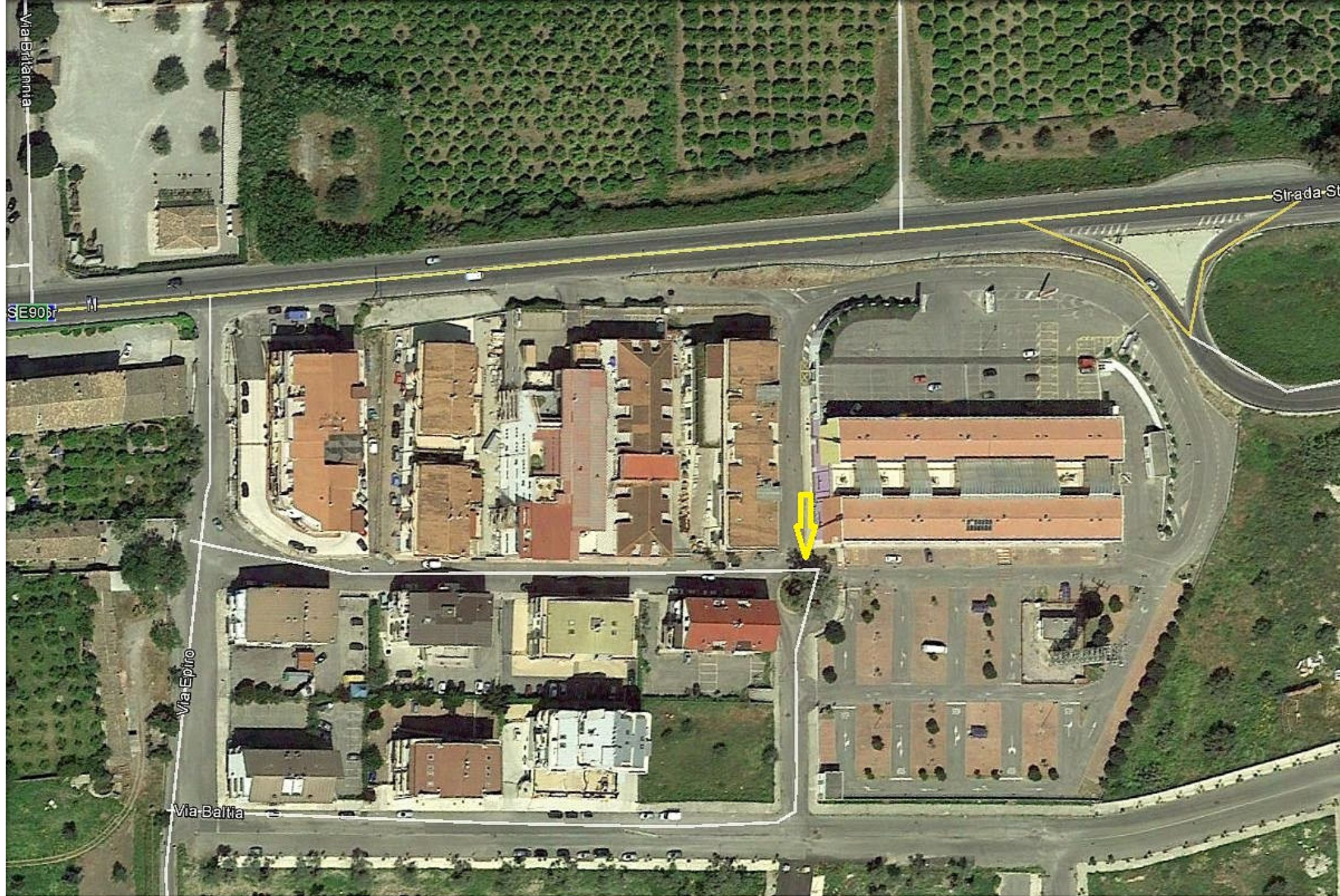
Via Baltia -C.da Amarelli- Aiuola 25 mq. con impianto di irrigazione.
